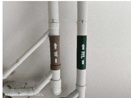
ท่อระบายน้ำฝนจากจากบนอาคาร (RL)
