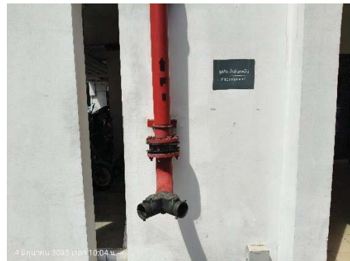
ท่อรับน้ำดับเพลิงอาคารละ 2 ชุด
