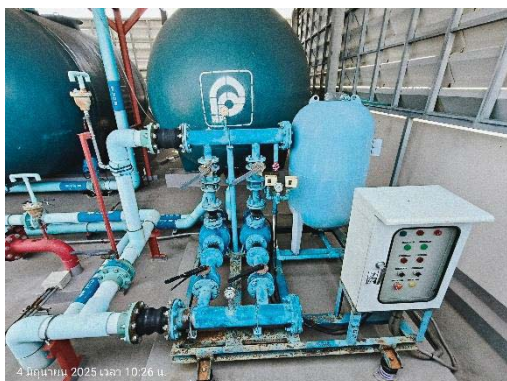
บูสเตอร์ปั๊มชั้นหลังคา อาคารละ 1 ชุด
